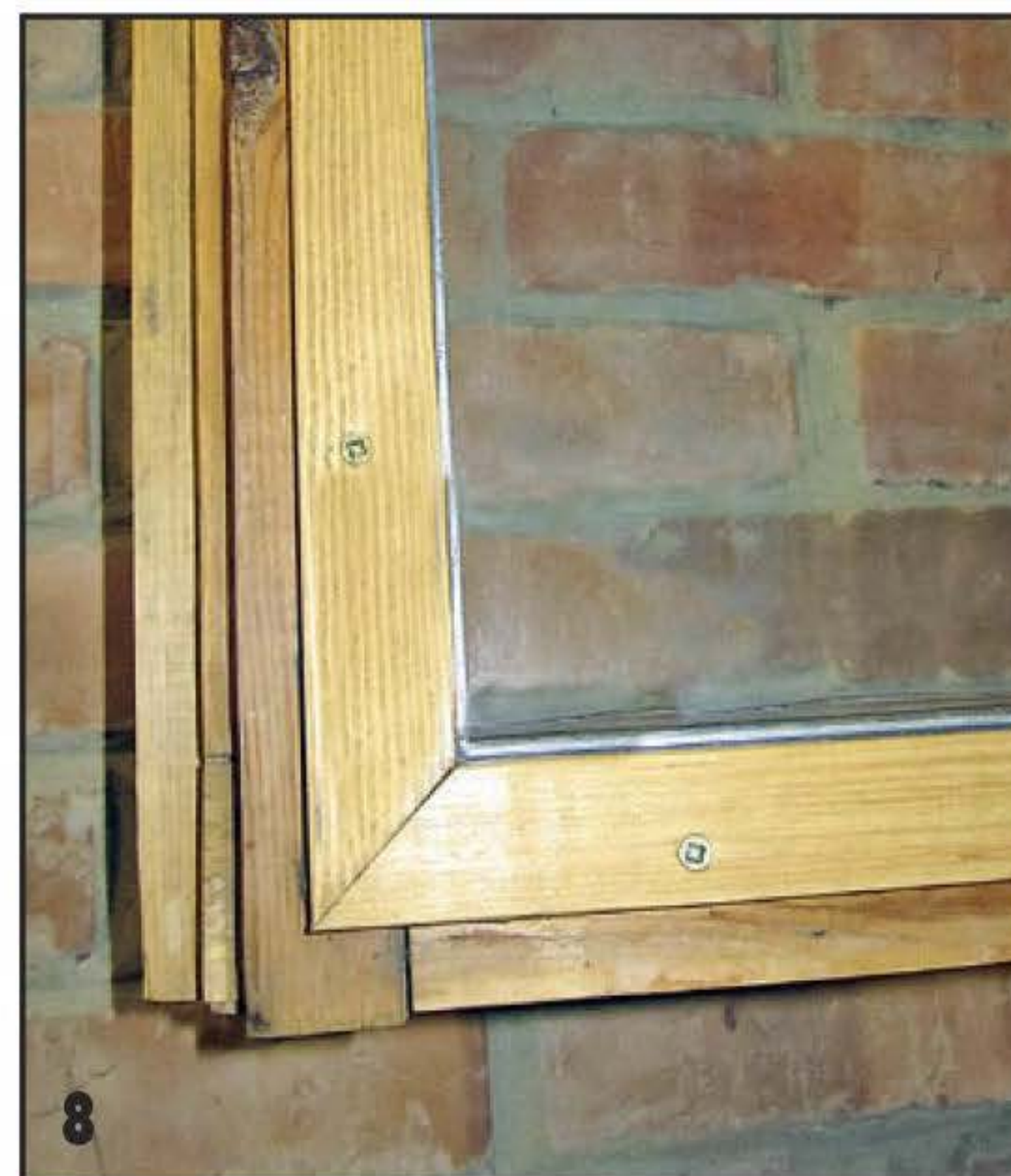
8 Снаружи стеклопакет закрепили рейками.
