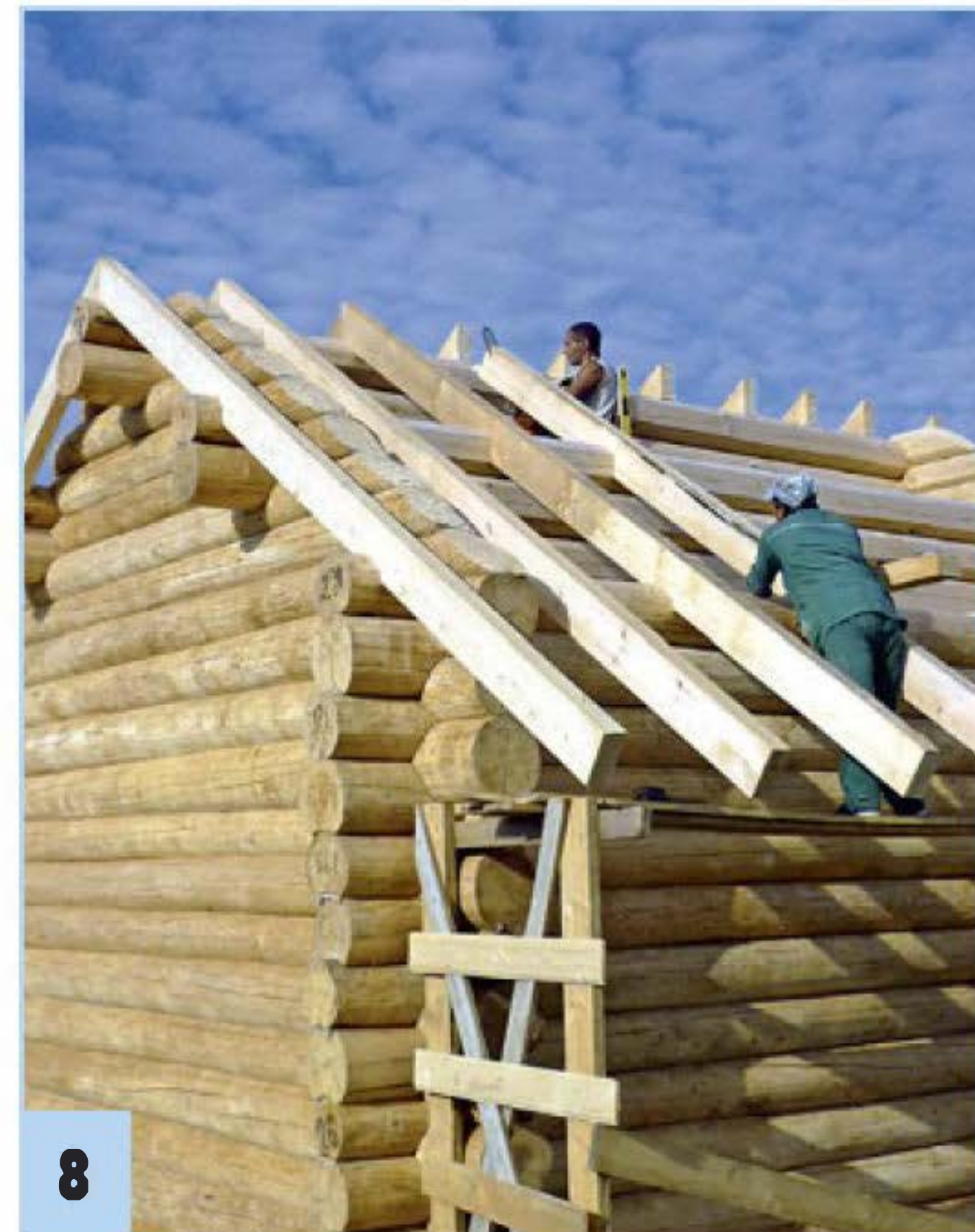
Стропило второго ската устанавливают, примеривают и по месту запиливают для стыковки с уже установленным стропилом.
