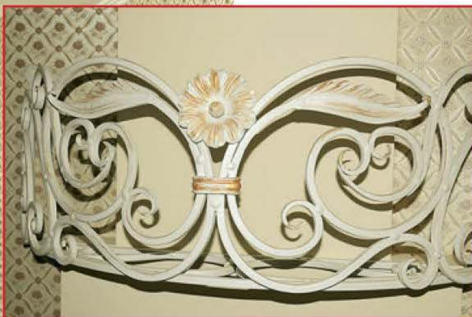
Кованый фальшбалкончик был изготовлен для «маскировки» выступающей колонны.
