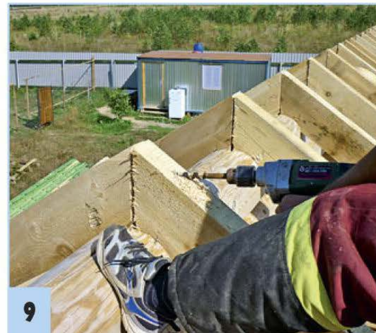
В верхней части состыкованных стропил сверлят...
