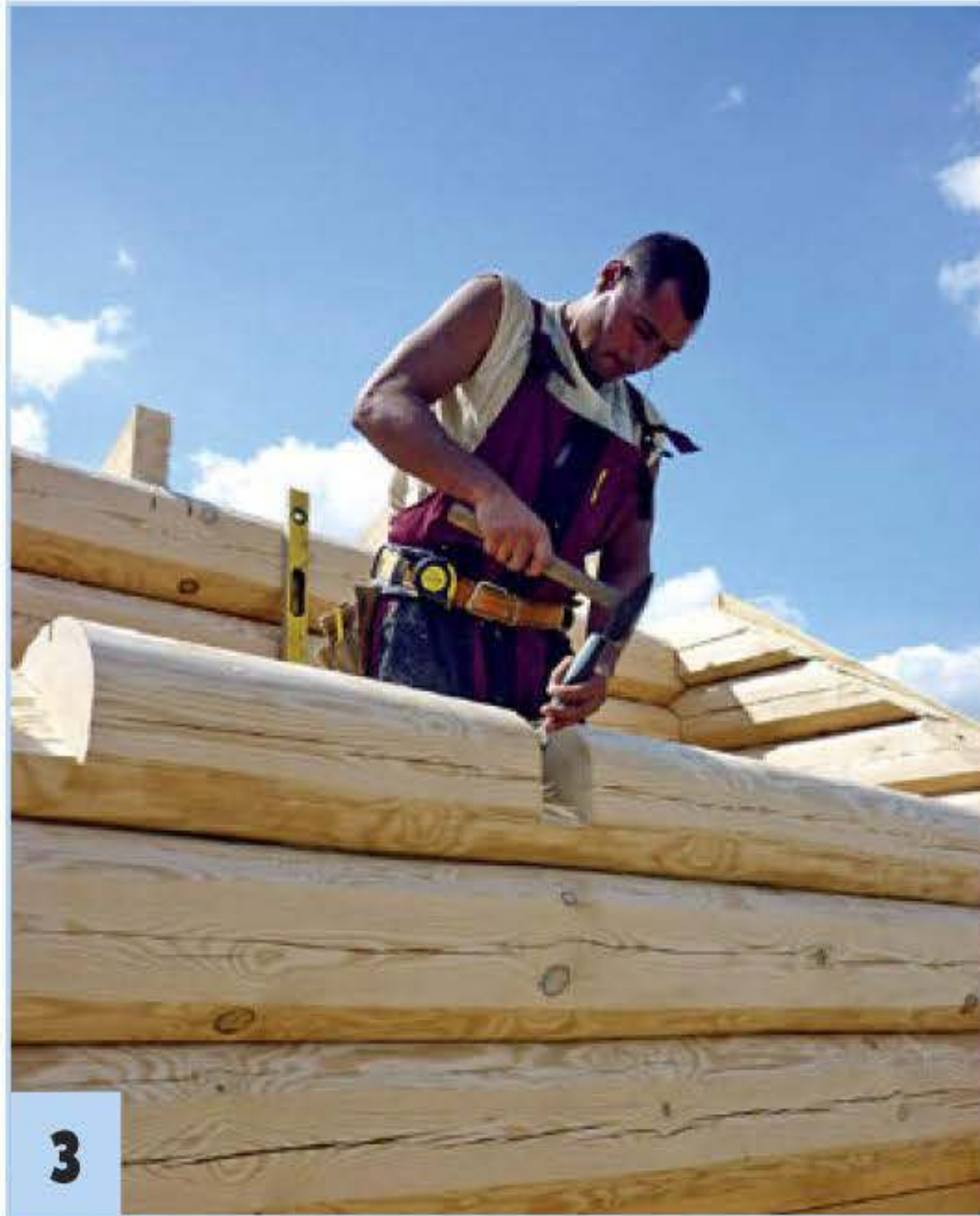
Под каждое стропило в верхнем бревне сруба, ...
