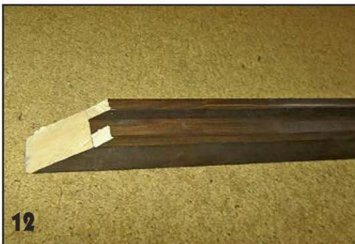
Установленный стеклопакет будет закреплён вторым бруском меньшего сечения.
