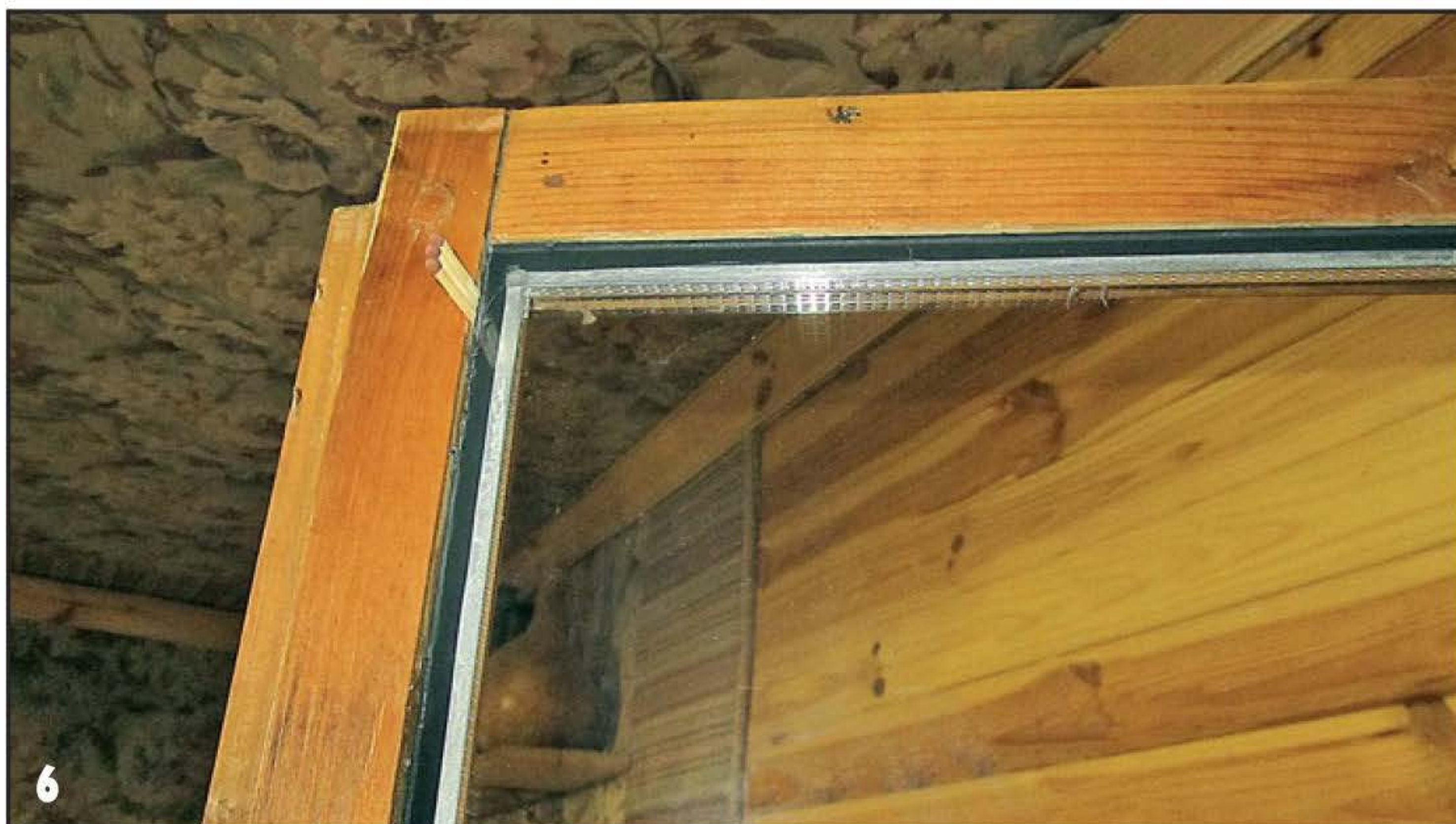
6 Стеклопакеты устанавливали на силикон, который наносили на тыльную полку фальца.
