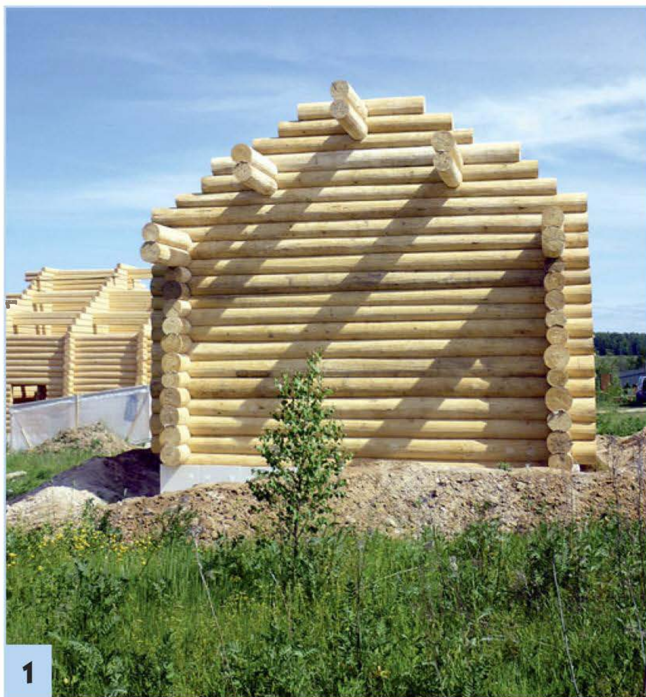
Строительство рубленого фронтона требует устройства кровли на скользящих стропилах.
