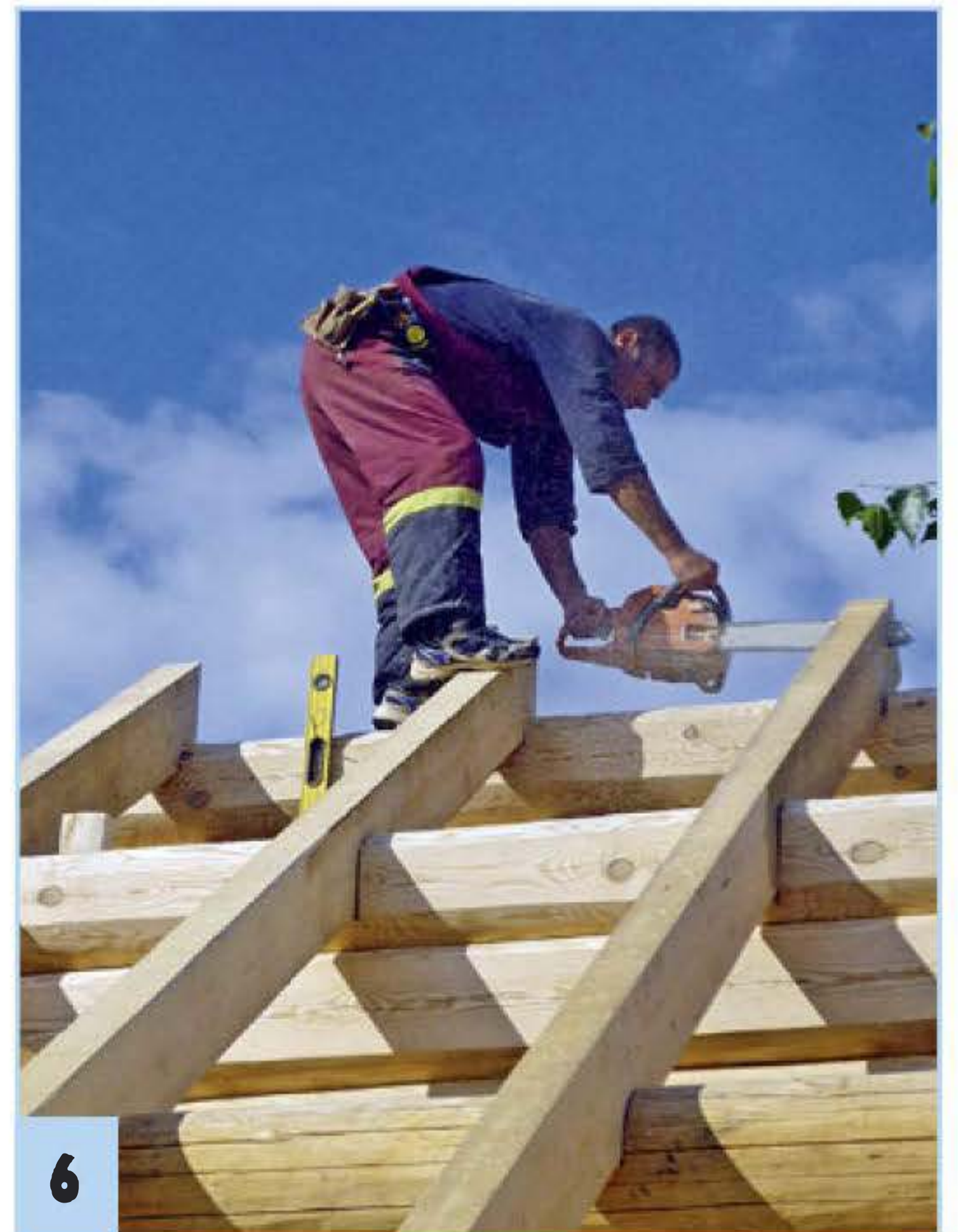
Установленные по одному скату стропила в коньке запиливают на ус для стыковки со стропилами противоположного ската.
