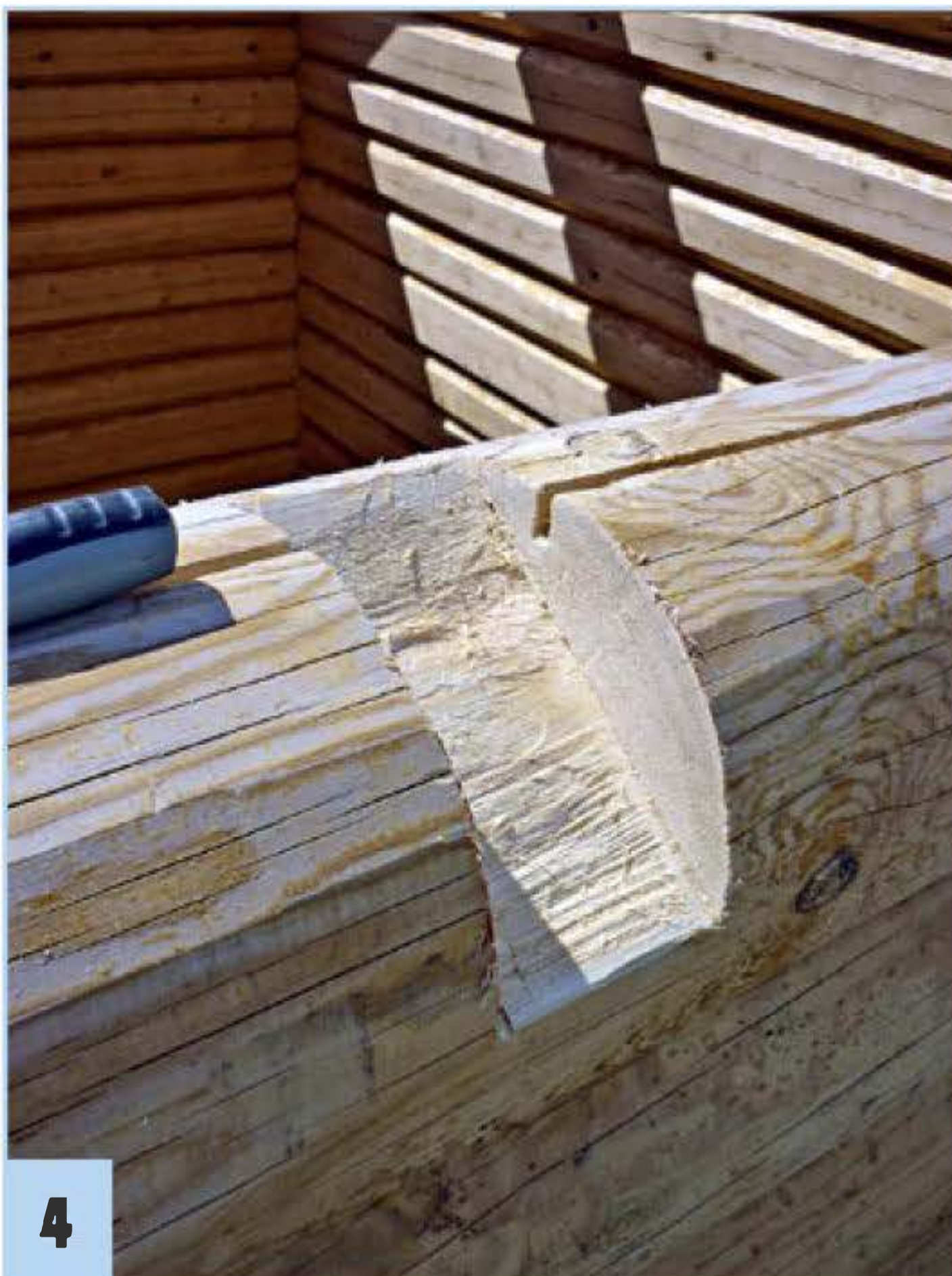
... а также в коньковом и промежуточных прогонах выбирается паз.
