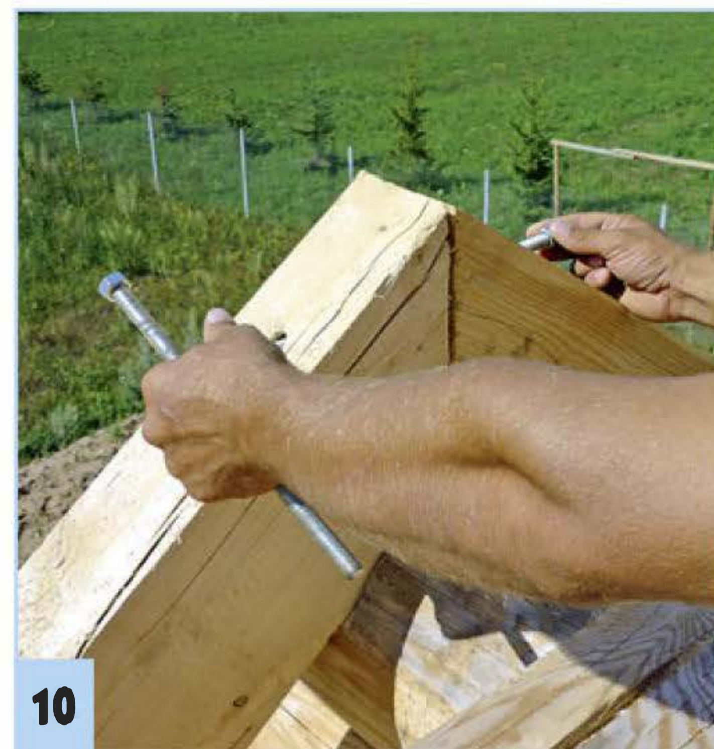
...отверстие под шпильку.
