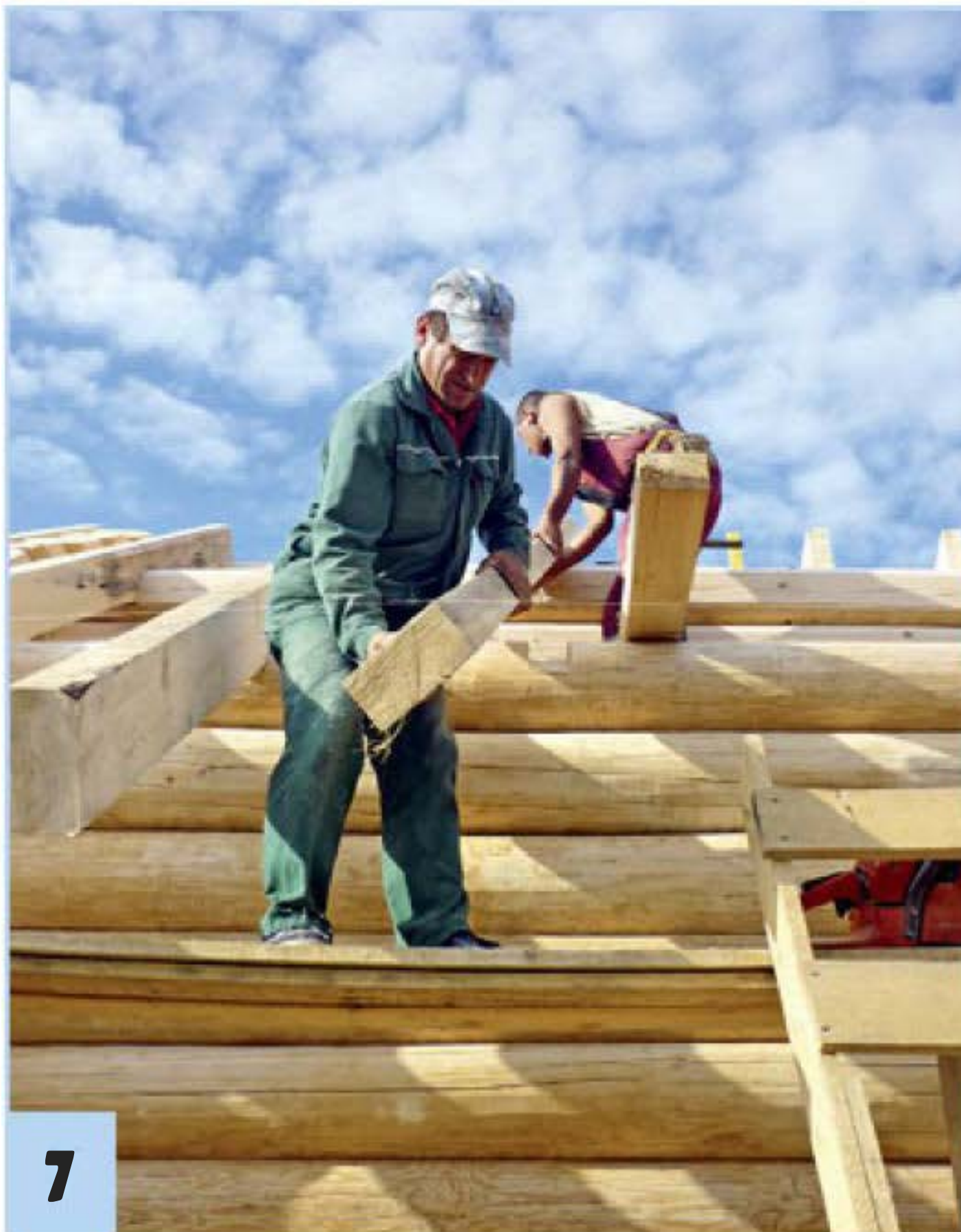
Стропило второго ската устанавливают, примеривают и по месту запиливают для стыковки с уже установленным стропилом.
