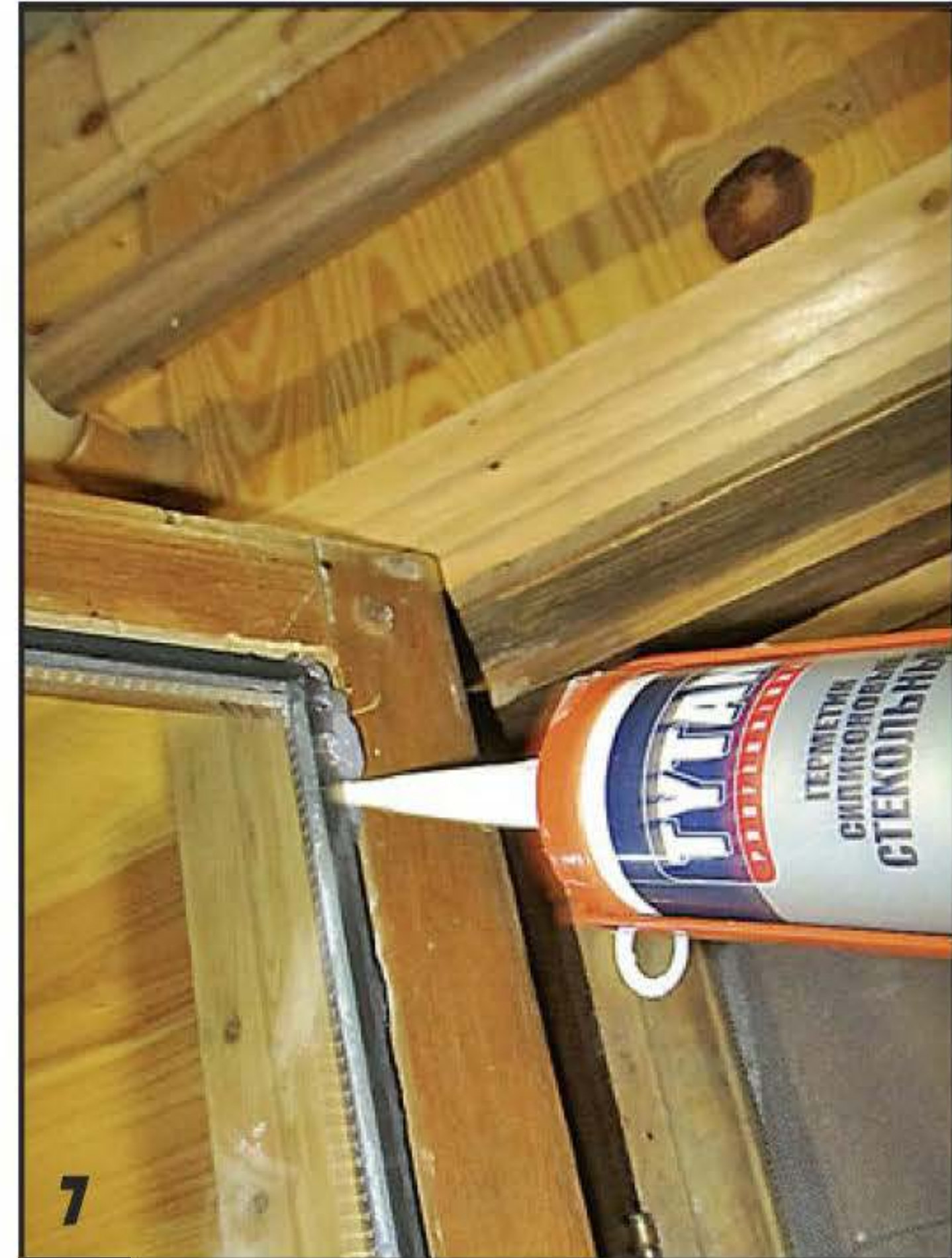
7 Щель по периметру стеклопакета промазали силиконовым герметиком.
