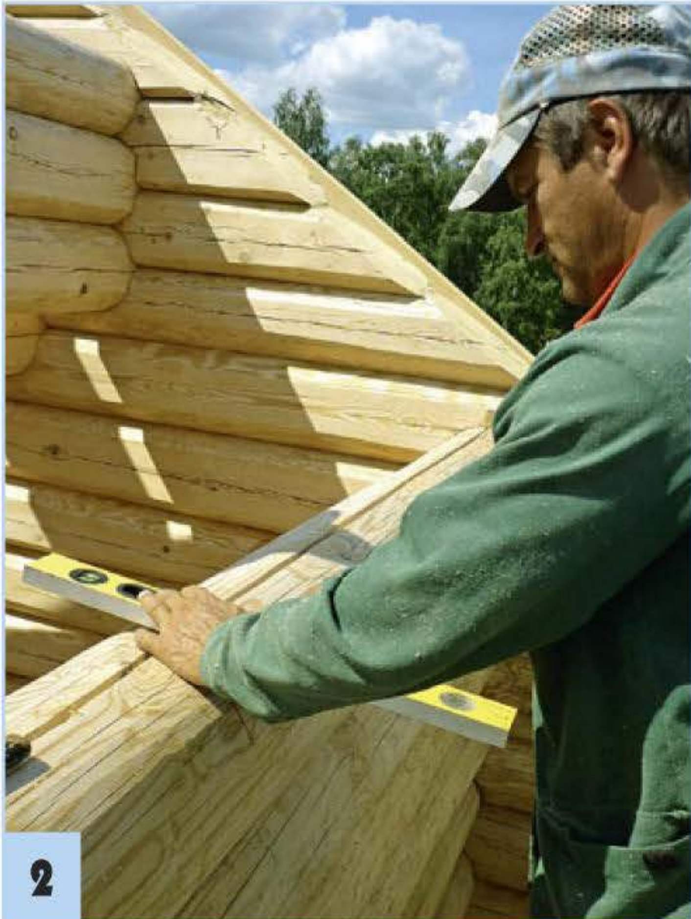
Разметка положения стропил.
